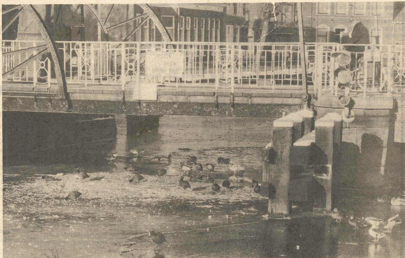
Het wak onder de brug bij de Bothniakade te Sneek is één van de problemen in de route.
